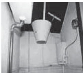
FIGURA 2. No banheiro, de sua casa de Petrópolis, Santos Dumont fez um chuveiro de água quente tendo o álcool por combustível. O calor da chama faz a água entrar em ebulição, subindo para um balde que possui duas alavancas: uma para misturar a água quente com a fria e outra para abrir o fundo de um balde, perfurado como regador de plantas. Assim, ele podia repetir o movimento quantas vezes julgasse necessário, tornando a ducha aquecida, um luxo inédito para a época. (Adaptado de http://novaescola.abril.com.br/index.htm )
